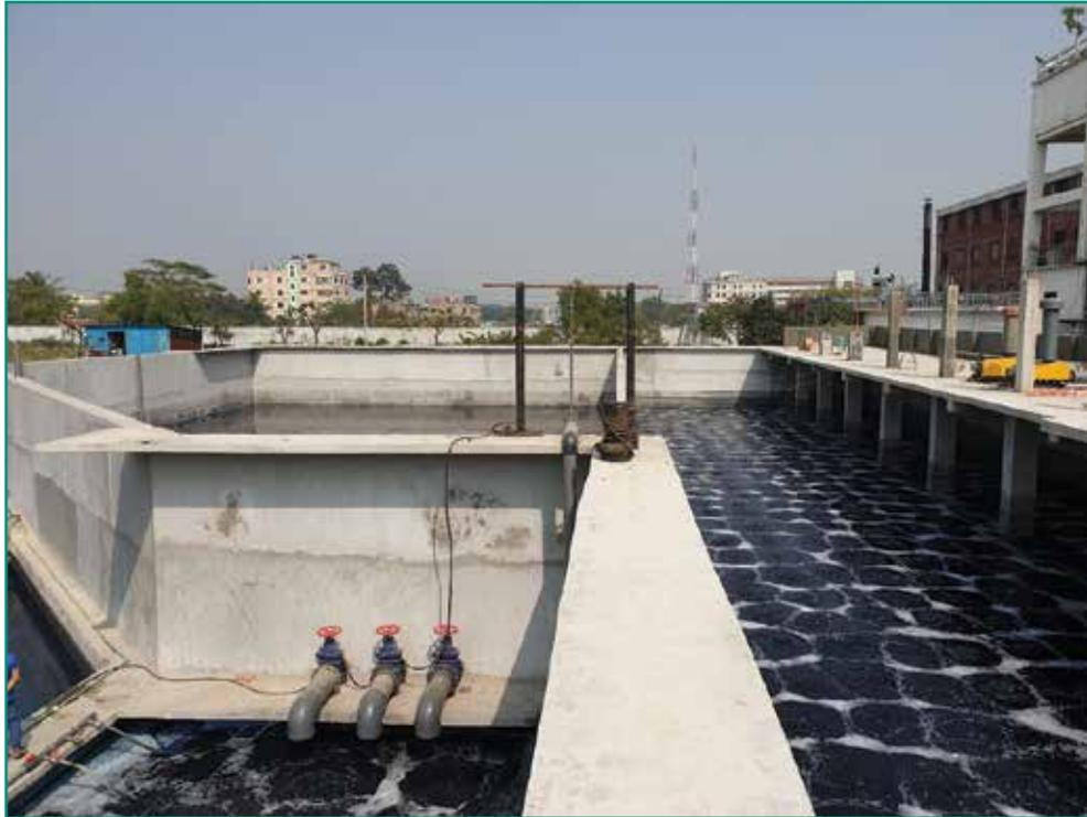
**Figura 4:** El nuevo tanque de equalización de 11,890 m<sup>3</sup>
