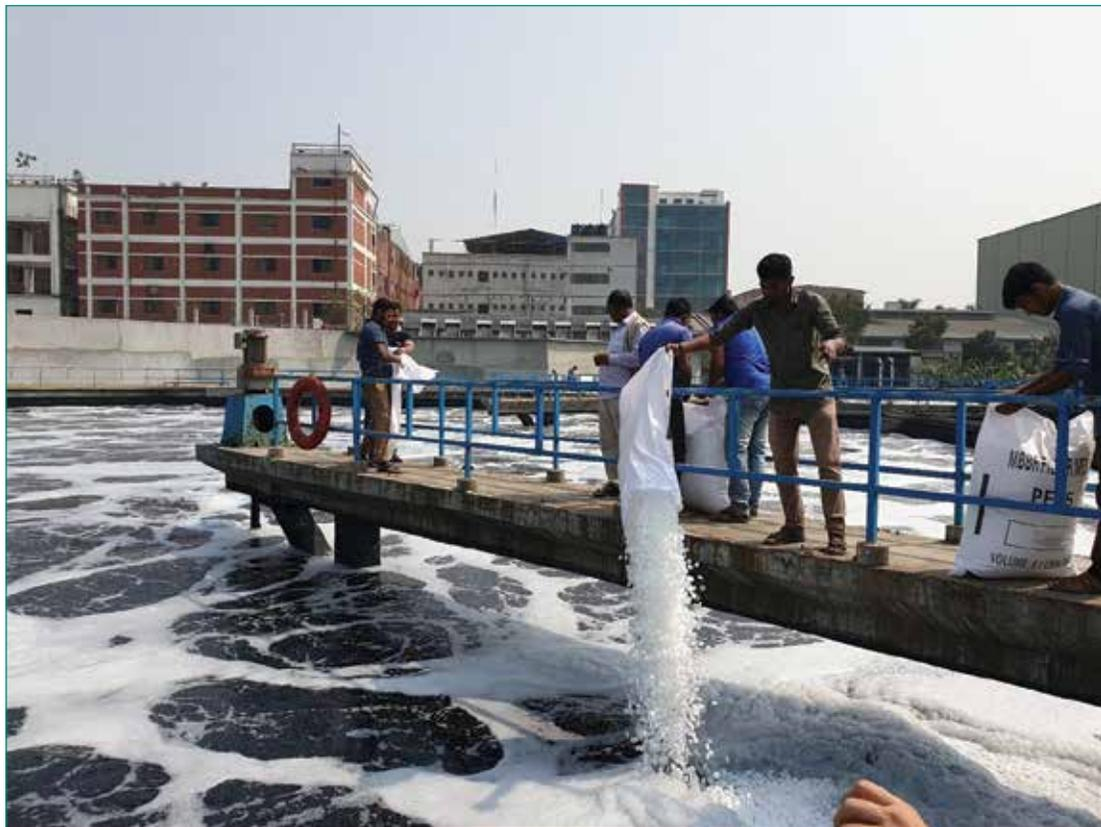
**Figura 7:** Aplicación de medio biológico en el tanque 8B
